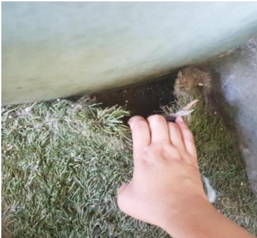
▲人工草皮下為水泥地，方便清洗，洛杉磯高溫乾熱天氣，清洗後很快能乾燥
