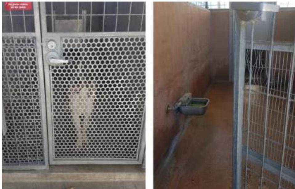
▲右圖為較舊籠舍，可見門網破損，左圖為陸續更換修繕籠舍門扇，可見不再用點焊鐵網，而改以沖孔板設計，與本市動物之家后里園區外籠區相同設計，顯見后里園區設計已具國際觀。
