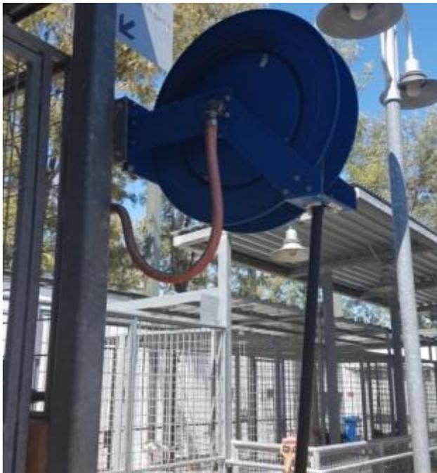
▲沖洗籠舍水管線路架設於上方，自動伸縮，該設計減少水管落地、雜亂，方便整理
