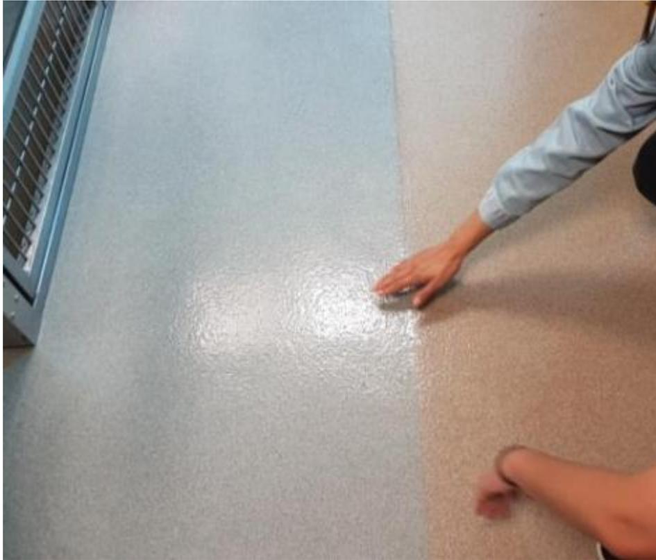
▲所方大力推薦地板材質，添加金剛砂類的地面，所方表示該地板耐用且易維護，但造價偏高，另淺綠色區塊，靠近犬舍處，下方埋熱水管，天氣冷時可啟用保暖措施
